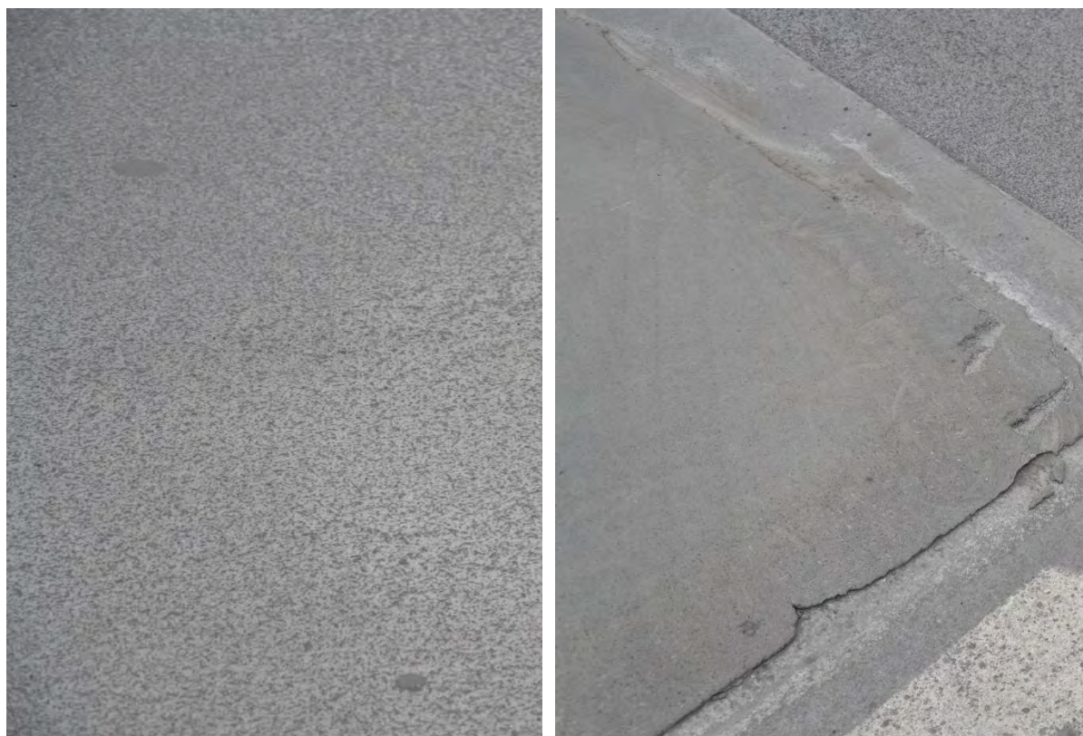
Figur 2.24 Akryl Duracon efter knappt 2 år på parkeringsdäck Baggen
