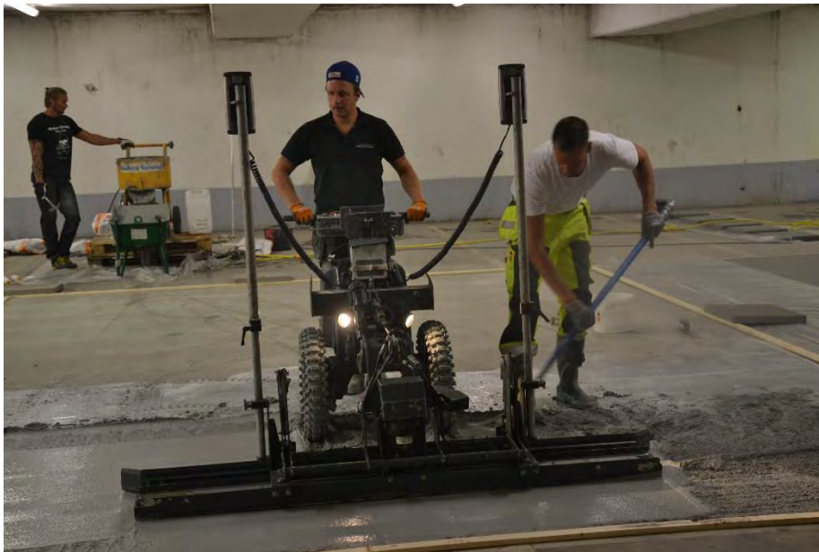
Utläggning av hårdbetong (Åkeshov 2014)
