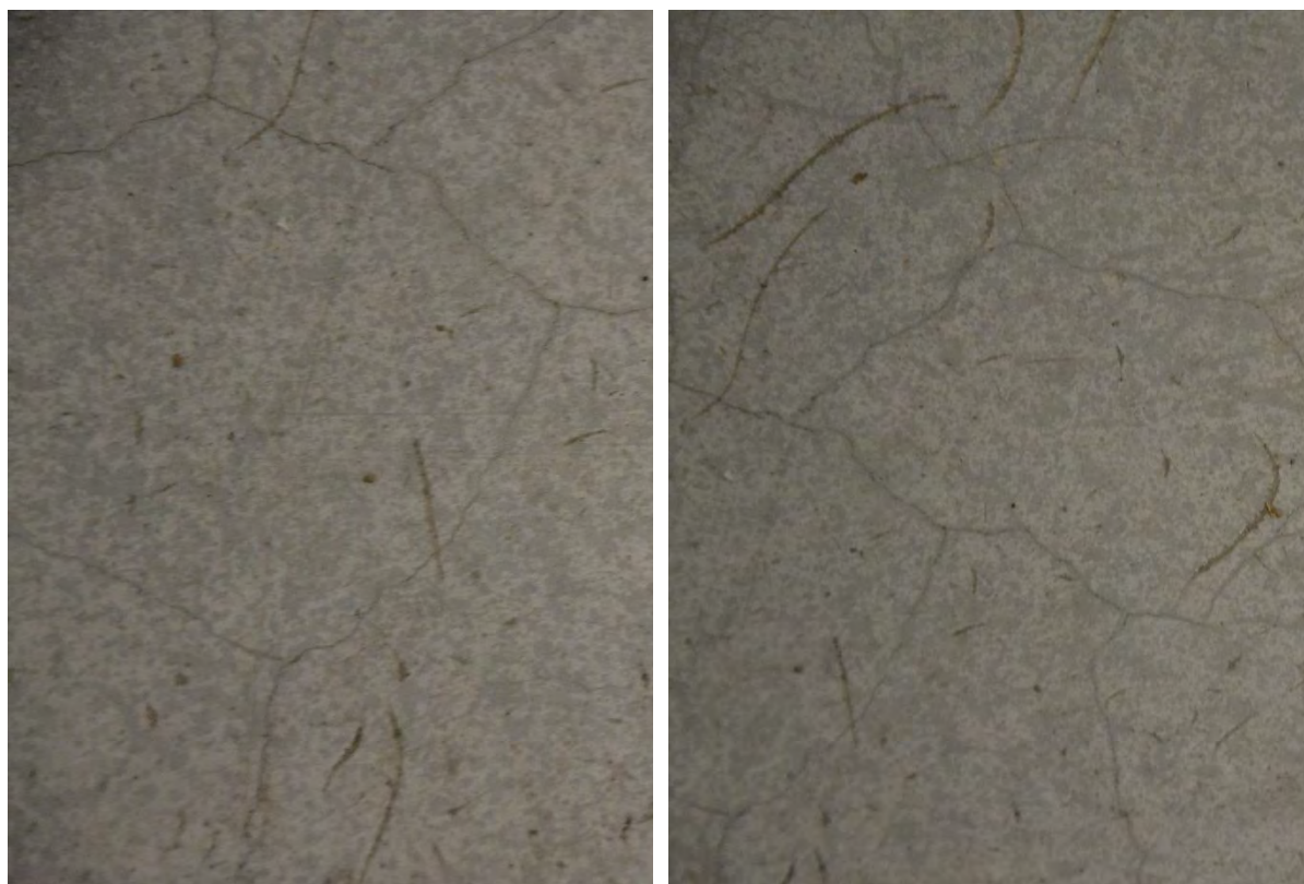
Figur 2.16 Hårdbetong Mastertop efter 3 år på parkeringsdäck Åkeshov
