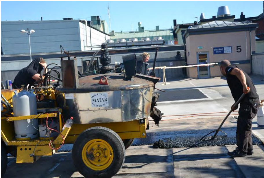
Utläggning av gjutasfalt på tätskiktsmatta (Baggen 2015)
