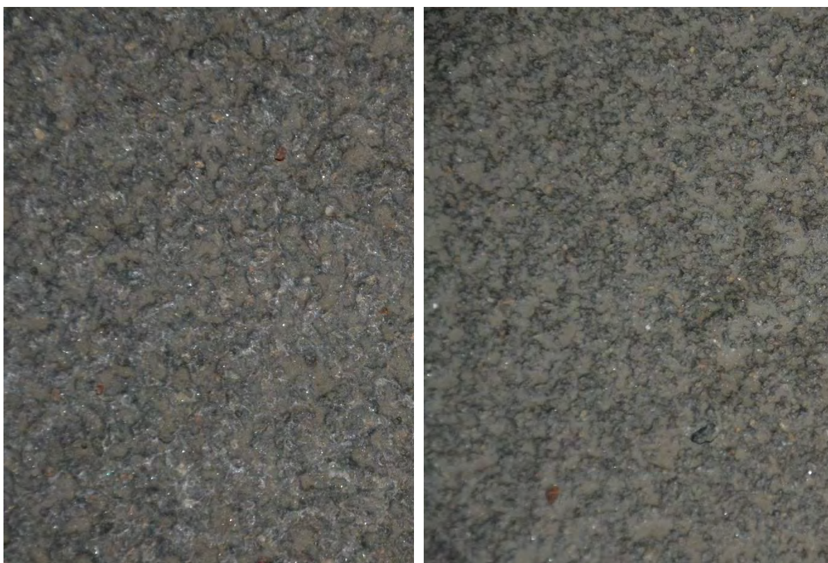
Figur 2.8 Akryl Map Pro efter 4 år på parkeringsdäck Kville
