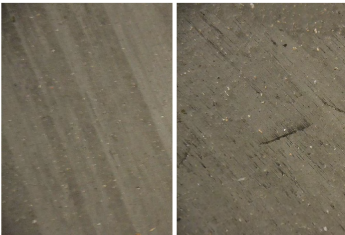
Figur 2.15 Polyuretan Ucrete efter 3 år på parkeringsdäck Åkeshov
