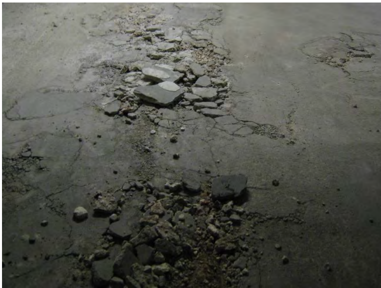
Figur 1.1 Betongskador i garage till följd av armeringskorrosion. Foto: Tor Powell.
