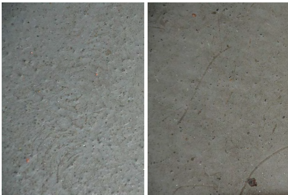
Figur 2.4 Polyuretan Deckshield ID efter 4 år på parkeringsdäck Kville
