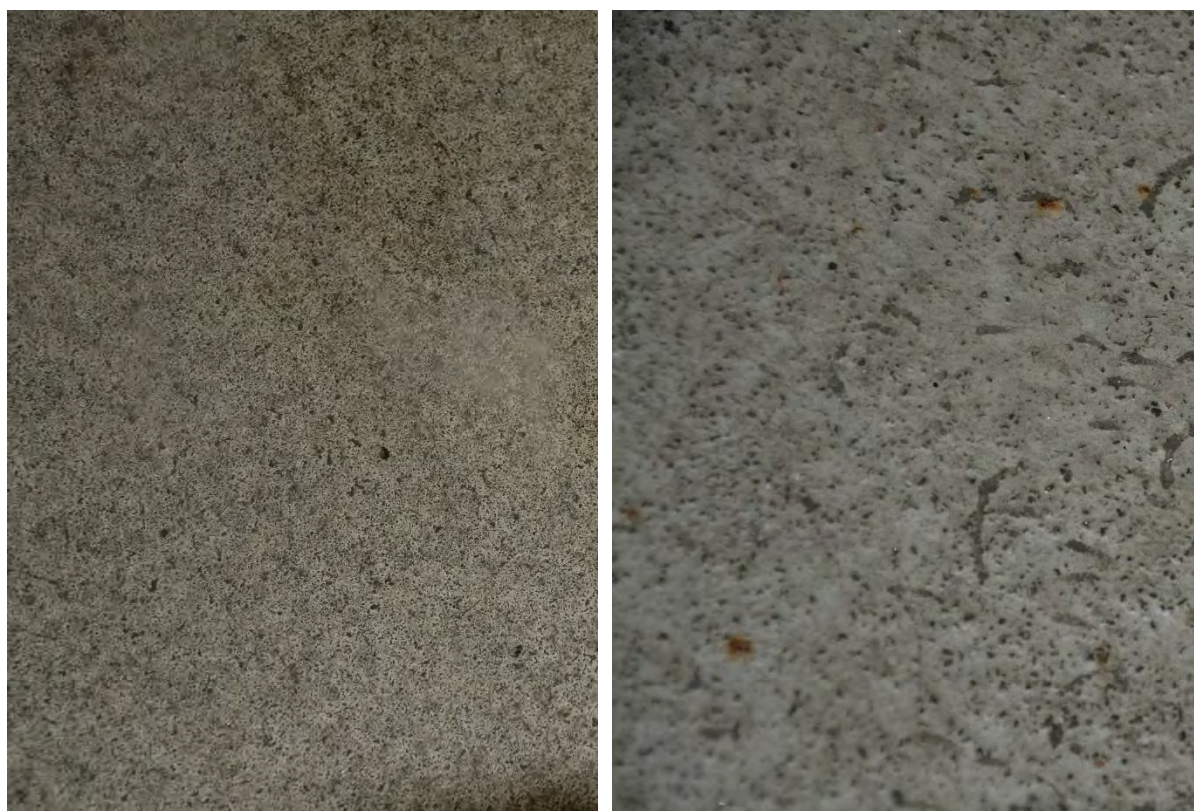
Figur 2.7 Polyuretan Conideck 2255 efter 4 år på parkeringsdäck Kville
