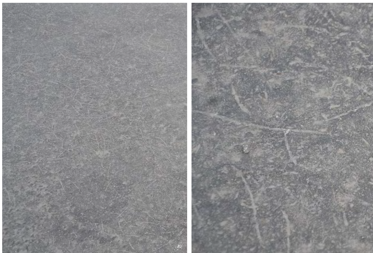
Figur 2.21 Gjutasfalt PGJA 11 efter knappt 2 år på parkeringsdäck Baggen
