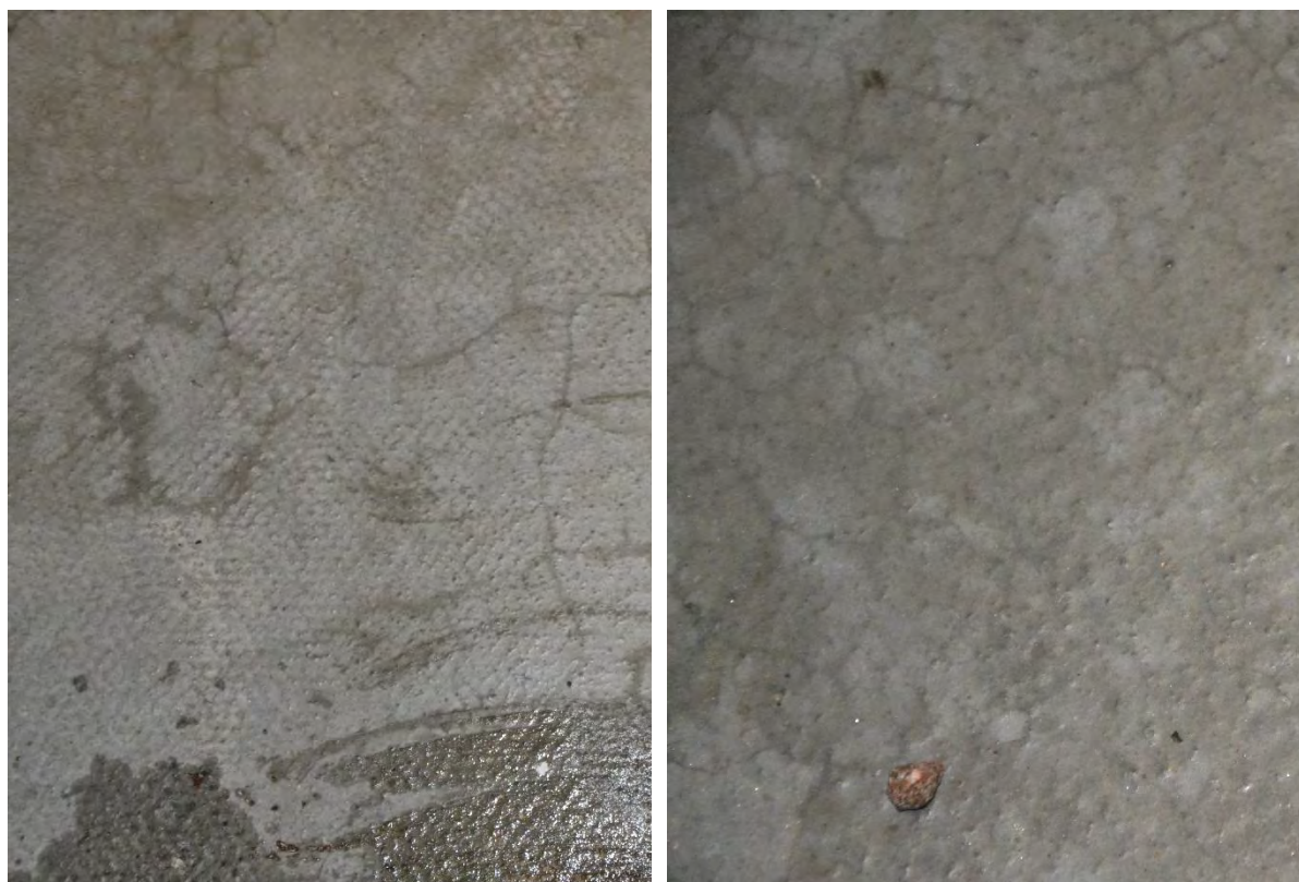
Figur 2.3 Polyuretan Deckshield ID efter 4 år på parkeringsdäck Kville
