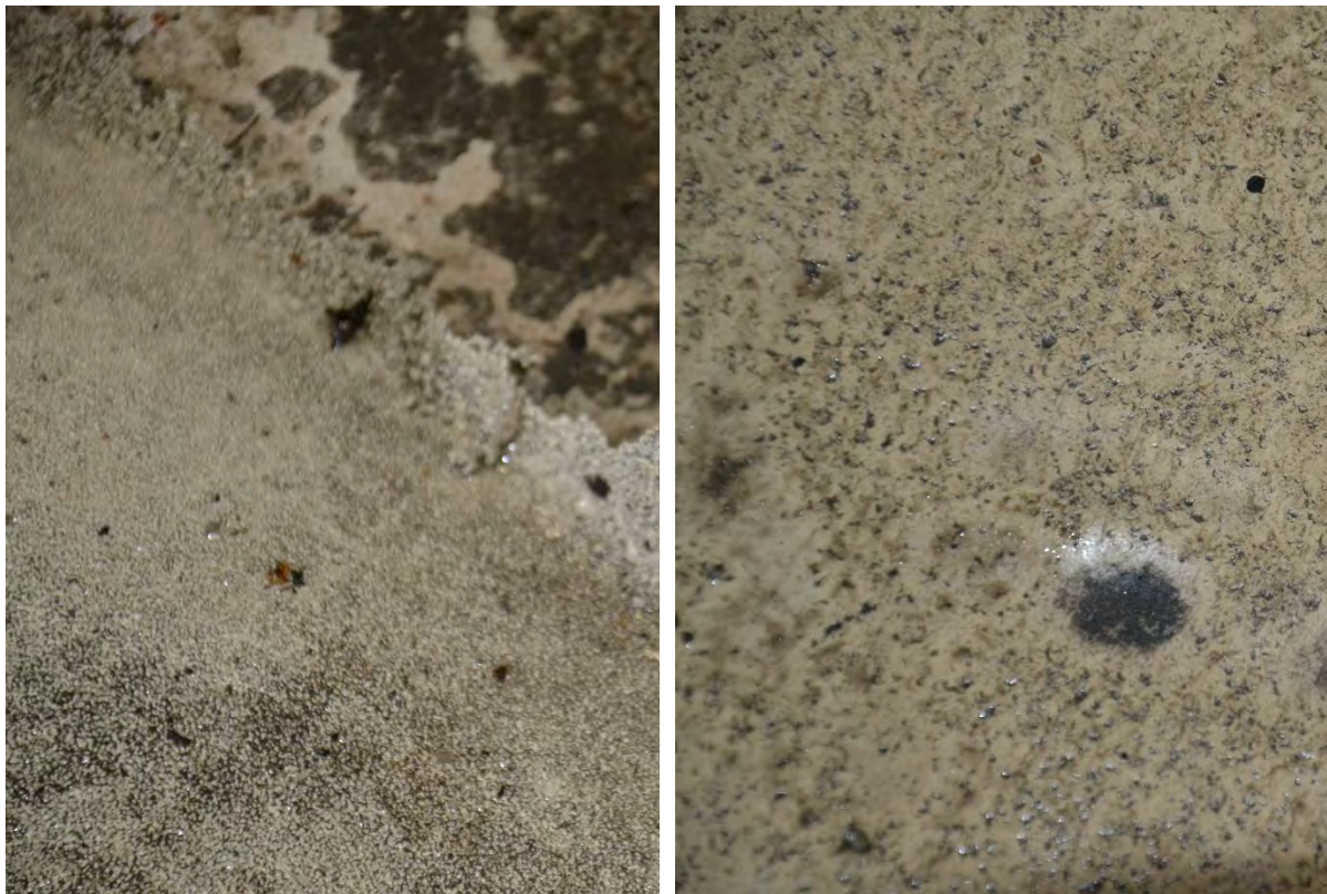
Figur 2.9 Polyurea Micorea S3 efter 4 år på parkeringsdäck Kville
