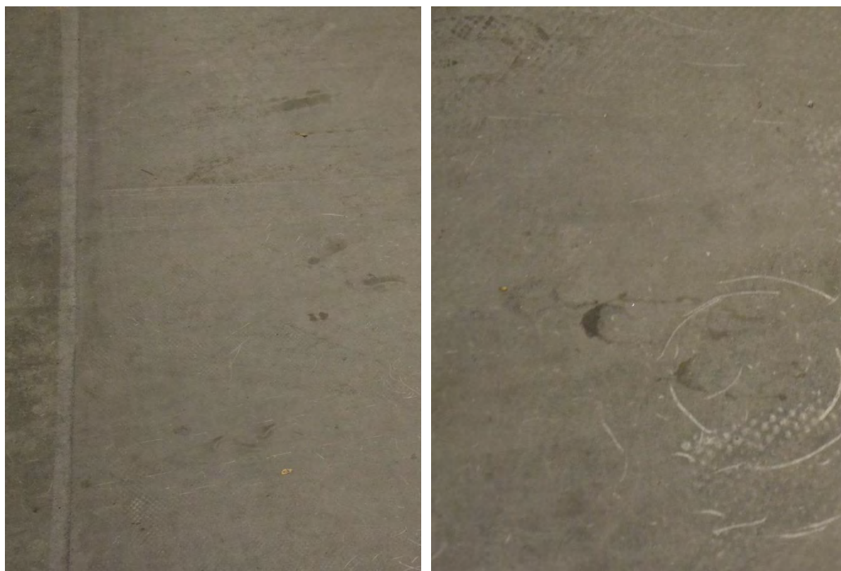
Figur 2.12 Hårdbetong Intercrete efter 3 år på parkeringsdäck Åkeshov
