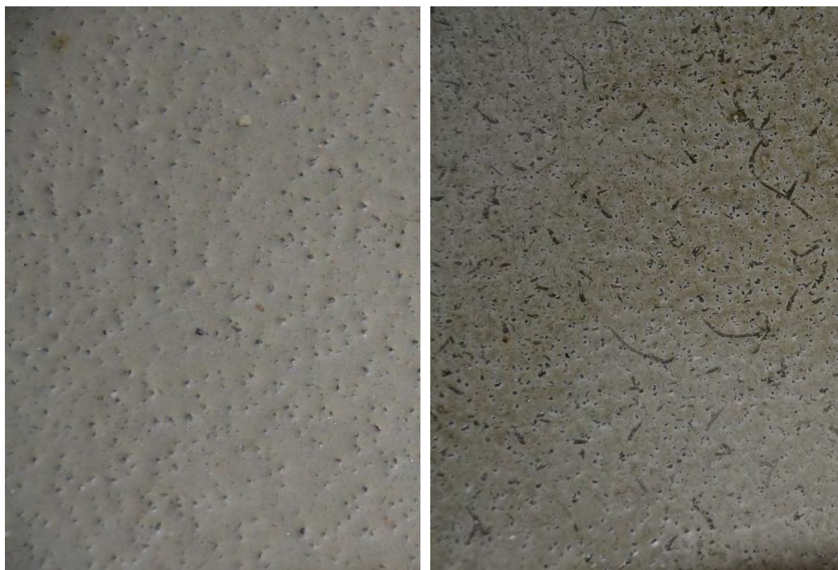
Figur 2.6 Polyuretan Deckshield ID efter 4 år på parkeringsdäck Kville
