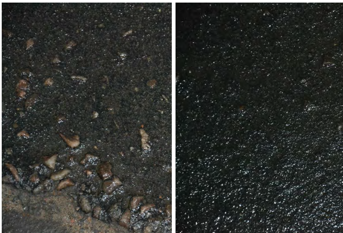
Figur 2.2 PGJA med vax och bromatta efter 4 år på parkeringsdäck Kville
