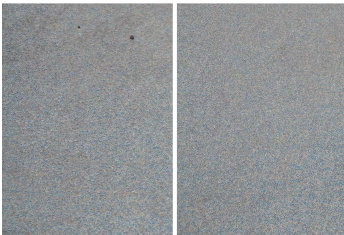
Figur 2.20 Akryl Silikal Struktur efter knappt 2 år på parkeringsdäck Baggen
