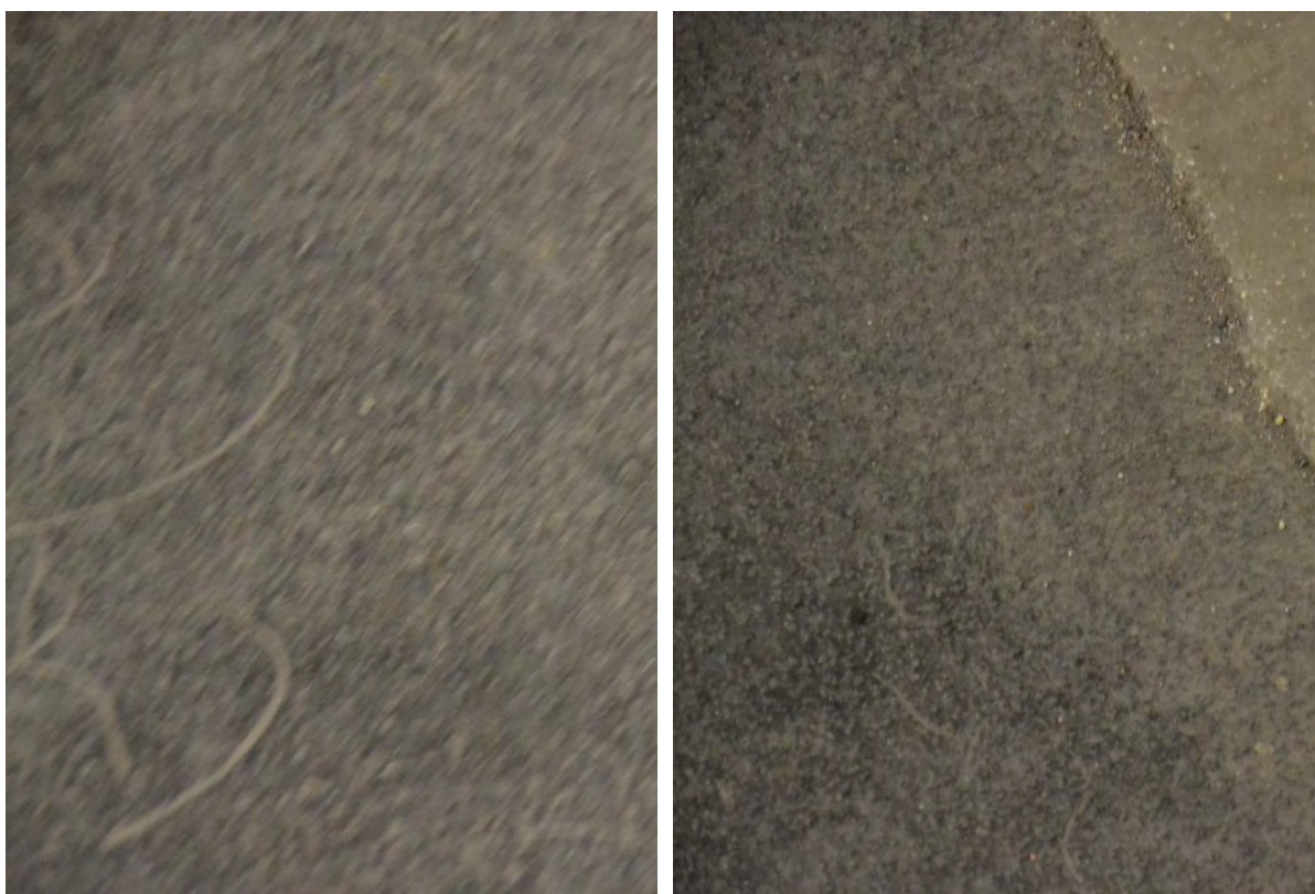
Figur 2.14 Akryl Duracon efter 3 år på parkeringsdäck Åkeshov
