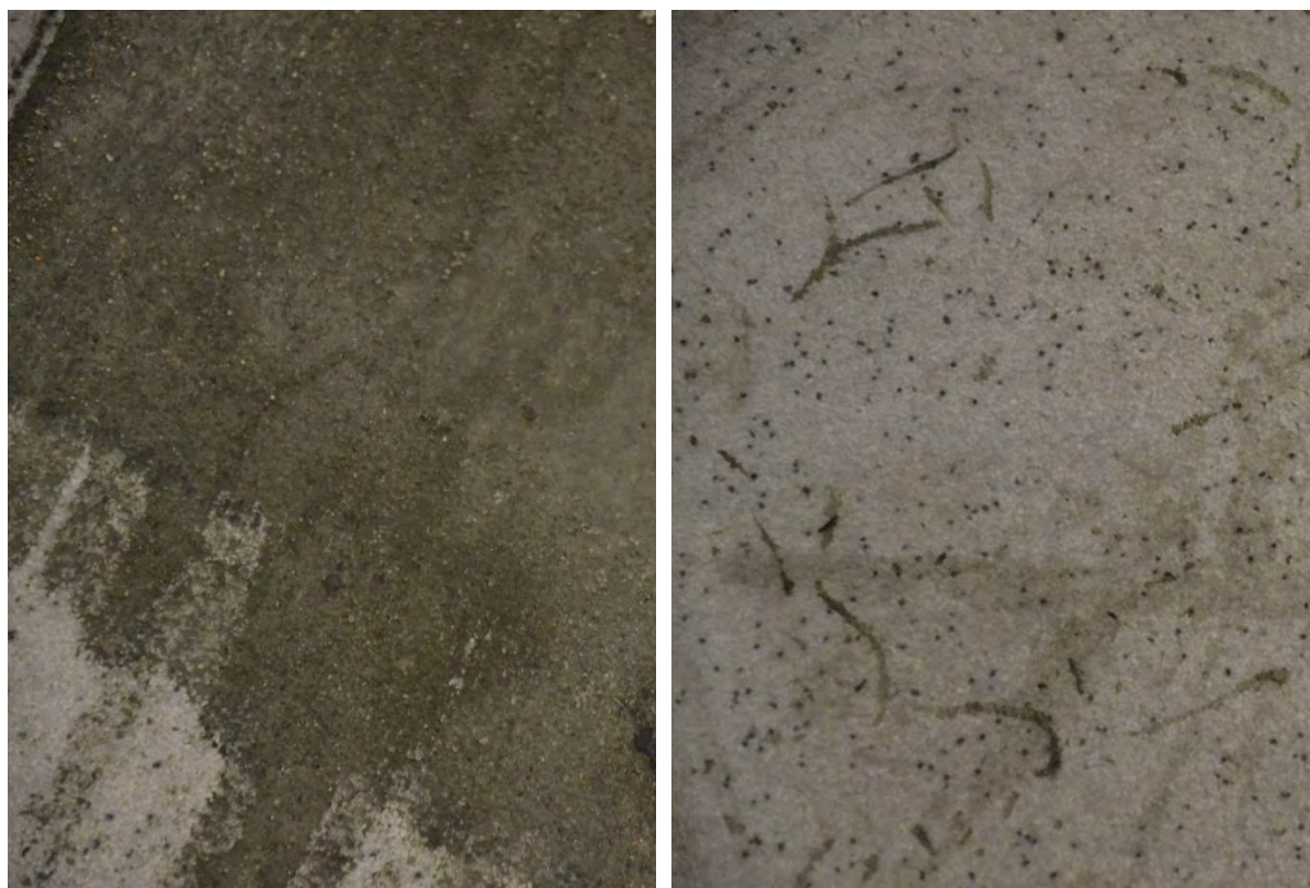
Figur 2.13 Akryl Silikal Dekor efter 3 år på parkeringsdäck Åkeshov
