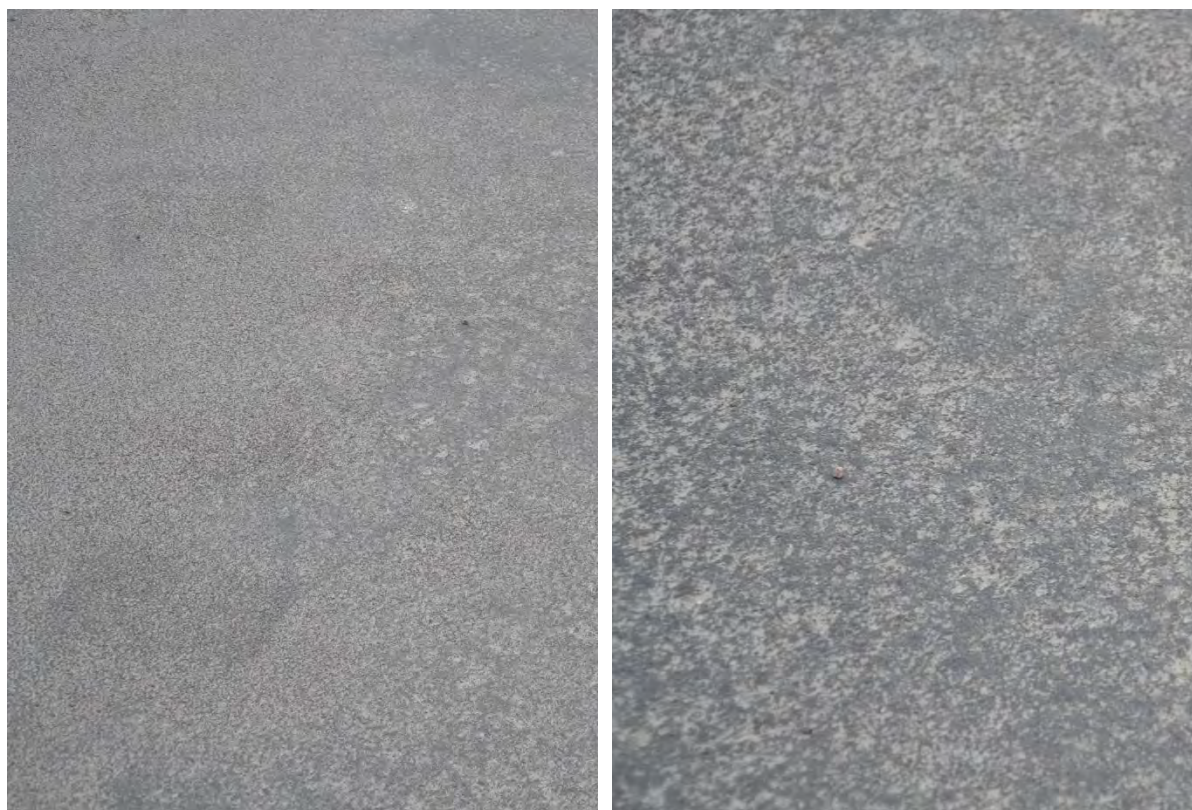
Figur 2.19 Polyurea Purtop 1000 efter knappt 2 år på parkeringsdäck Baggen
