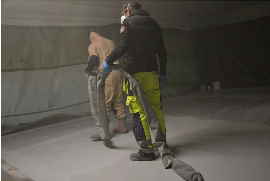
Sprutapplicering av polyurea (Kville 2013)
