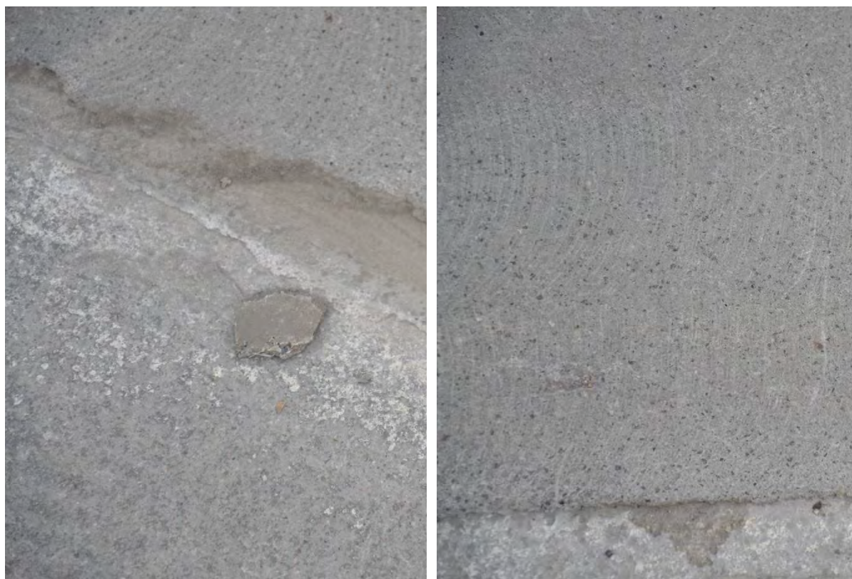
Figur 2.23 Hårdbetong Sikafloor-1 Corcrete efter knappt 2 år på parkeringsdäck Baggen
